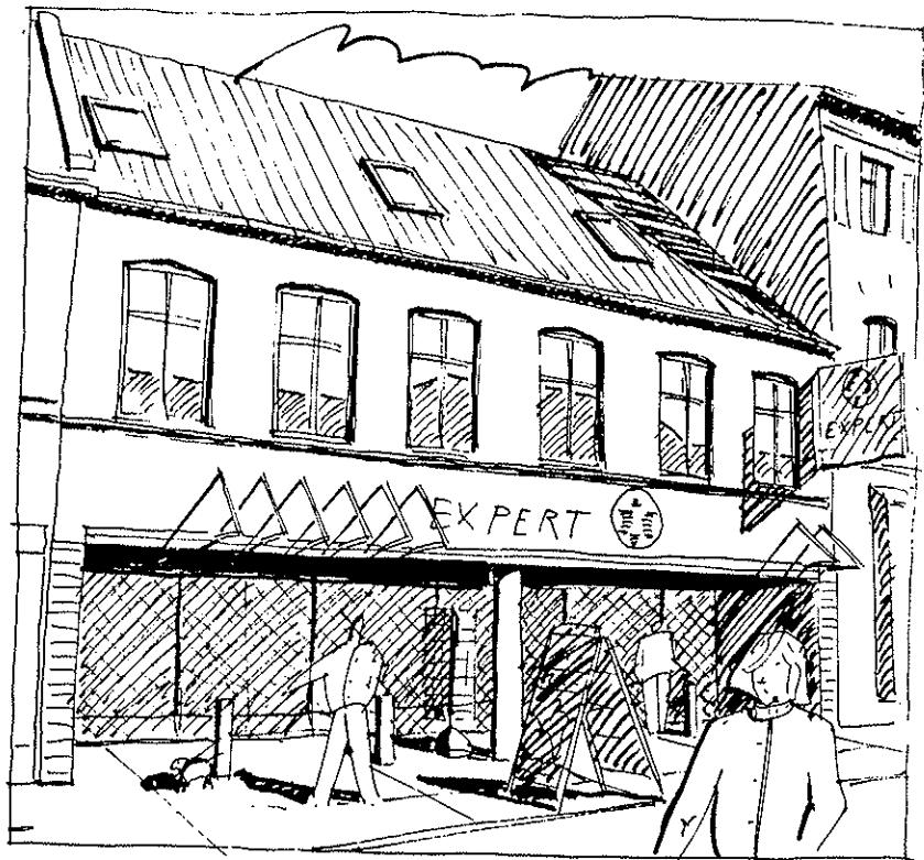
Rosengade 11, som bygningen tager sig ud i dag. Bunden er skåret væk og erstattet af en søjle.
