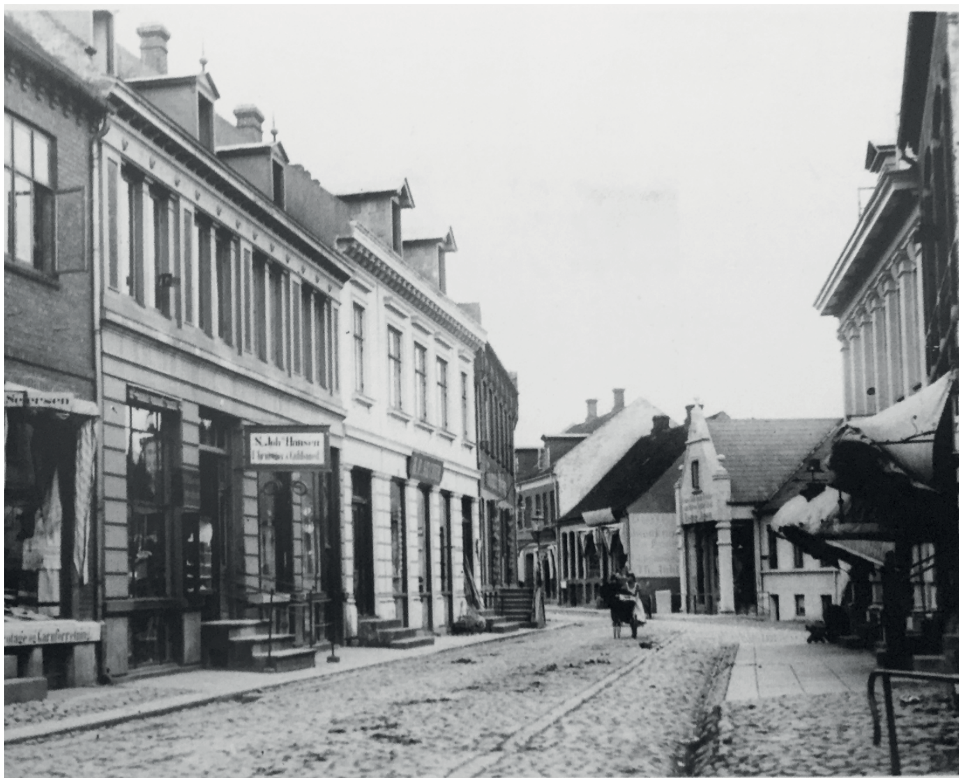
Gadeforløb langs Rosengade mod Raupachgade, start 1900
