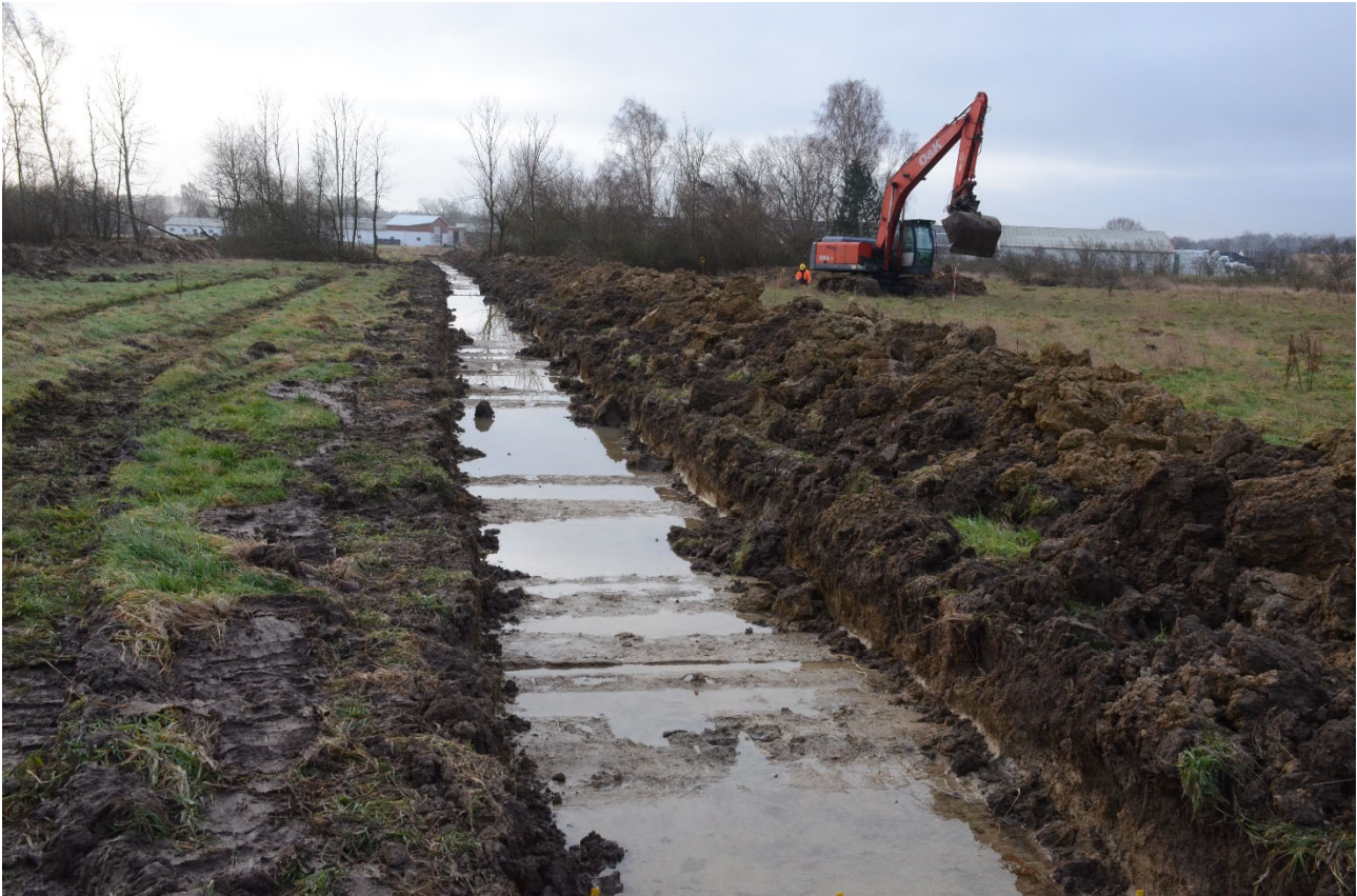
Fig. 4. Mange af søgegrøfterne blev hurtigt vandfyldt pga. indsvivende grundvand. Dette vanskeliggjorde arbejdet. Set fra N.
